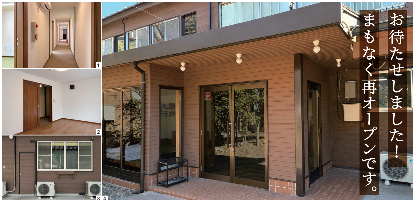
1.川側の2部屋が室内で移動できるよう中廊下が新設されました。2.改装された2部屋。二段ベッドが3台置かれ、6名定員となります。3.グラウンド側の3部屋は床の強度を上げ、換気扇を設置しました。4.外壁はB館と同じサイディングにし、屋根や玄関周り、ドア部分などは再塗装を施して、建物全体の耐久性を向上しました。
